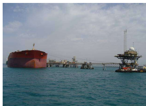
バスラ・オイル・ターミナル （原油出荷施設）訪問
